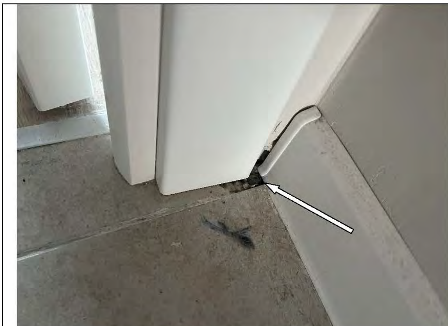
Фото №22. Короткая подрезка напольной керамической плитки в коридоре.
