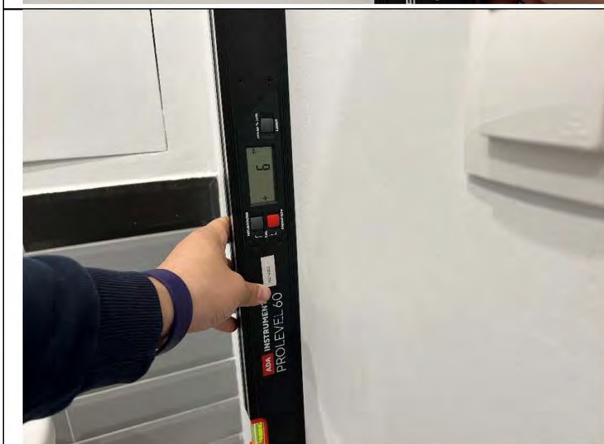
Фото №8. Измерение уровня стен в ванной комнате.
