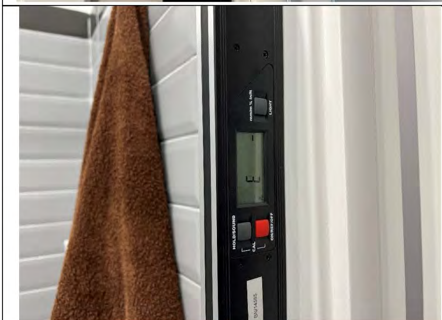
Фото №41. Отклонение наличников дверного блока в ванной комнате равно 3 мм.
